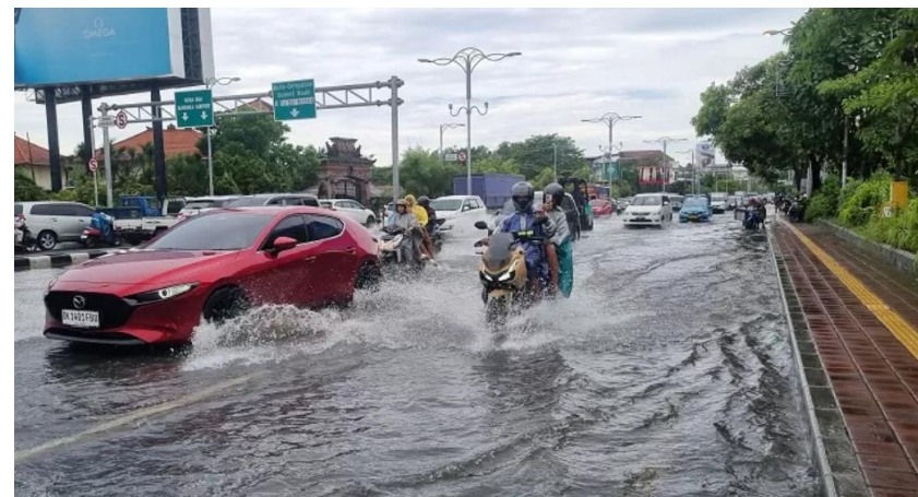
Kondisi Jalan di Kecamatan Kuta Selatan
