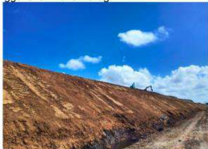
Penutupan Sampah Menggunakan Tanah Urug
