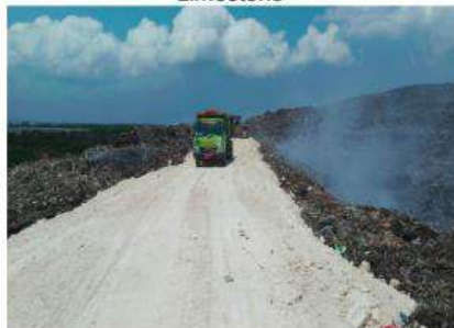
Penutupan Sampah Menggunakan Tanah Urug
