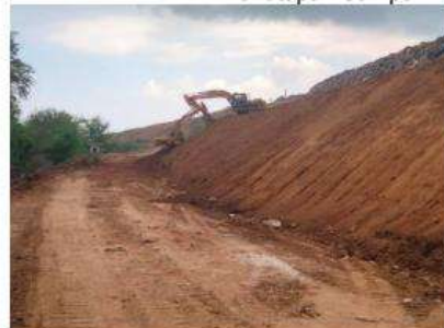
Penutupan Sampah Menggunakan Tanah Urug
