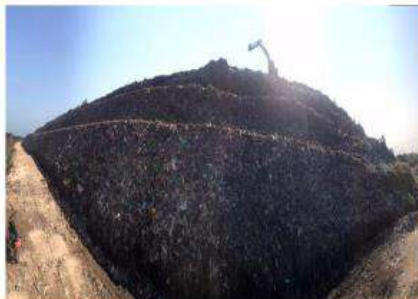
Penutupan Sampah Menggunakan Tanah Urug
