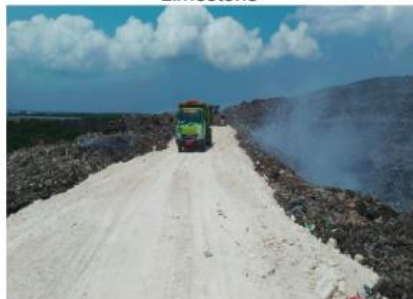
Penutupan Sampah Menggunakan Tanah Urug
