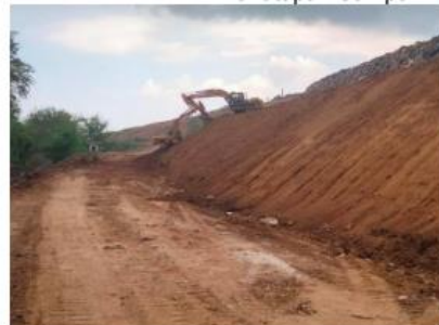
Penutupan Sampah Menggunakan Tanah Urug
