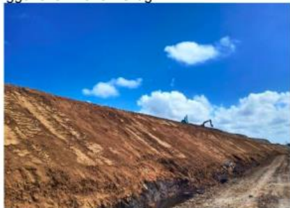
Penutupan Sampah Menggunakan Tanah Urug
