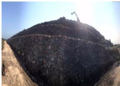
Penutupan Sampah Menggunakan Tanah Urug
