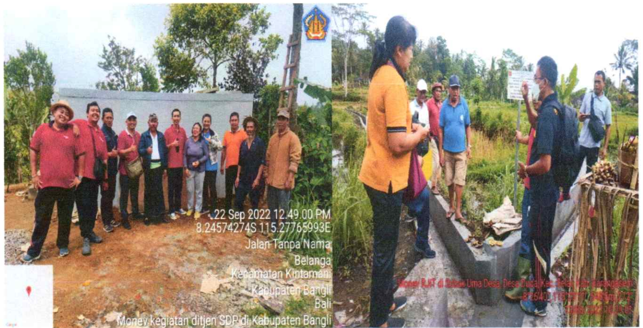
PEMBANGUNAN EMBUNG DAN REHABILITASI JARINGAN IRIGASI TERSIER (RJIT)
